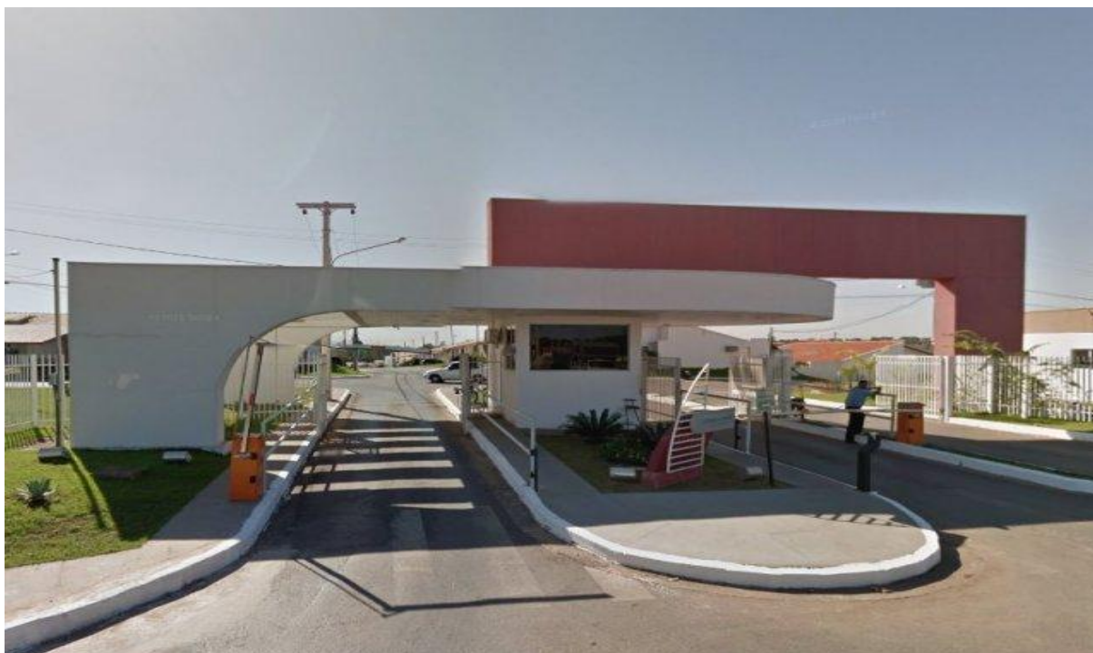
Figura - 9 - Portaria do Condomínio Terra Nova Várzea Grande. (Fonte – E.R.Silva, 2019)
